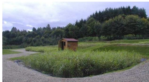
Station d'épuration par filtres plantés de roseaux (Source photo : sint.fr)
